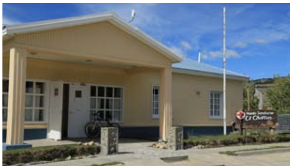
Puesto Sanitario El Chaltén. Foto SIIC
