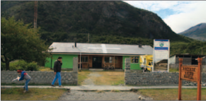
Posta de Salud Rural Villa O'Higgins. Foto SIIC
